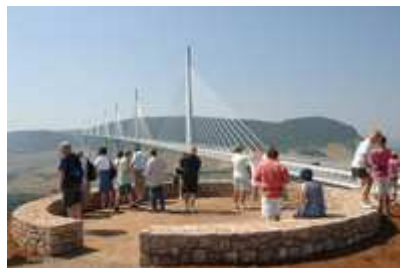
Viaduc de Millau
